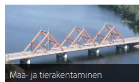
Maa- ja tierakentaminen
